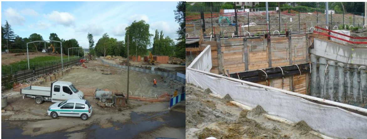
Photographies du chantier RATP de suppression du PN n°27 à Gif-sur-Yvette (Source : RATP)
