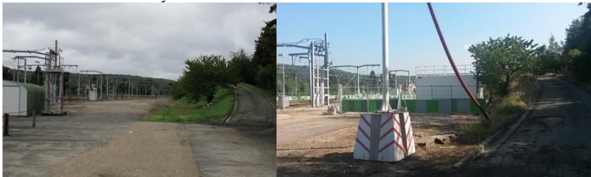
Emplacement envisagé pour la zone de chantier en arrière gare de Saint-Rémy-lès-Chevreuse (à gauche) et aire de chantier RATP existante à Saint-Rémy-lès-Chevreuse en 2016 (à droite) (Source : Dossier d’enquête publique)
