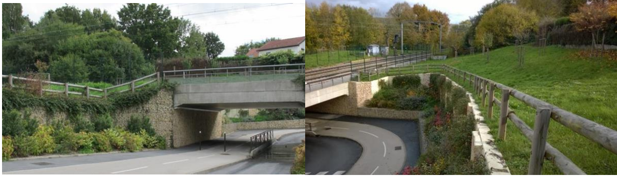
Photographies de l'ouvrage routier inférieur définitif suite à la suppression du PN n°27 à Gif-sur-Yvette (Source : RATP)
